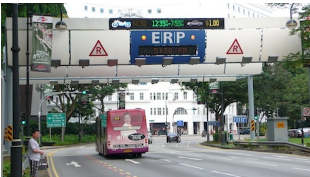
Photo 2 : portique de télépéage à Singapour © J.-Ch. Gay, 2011.
