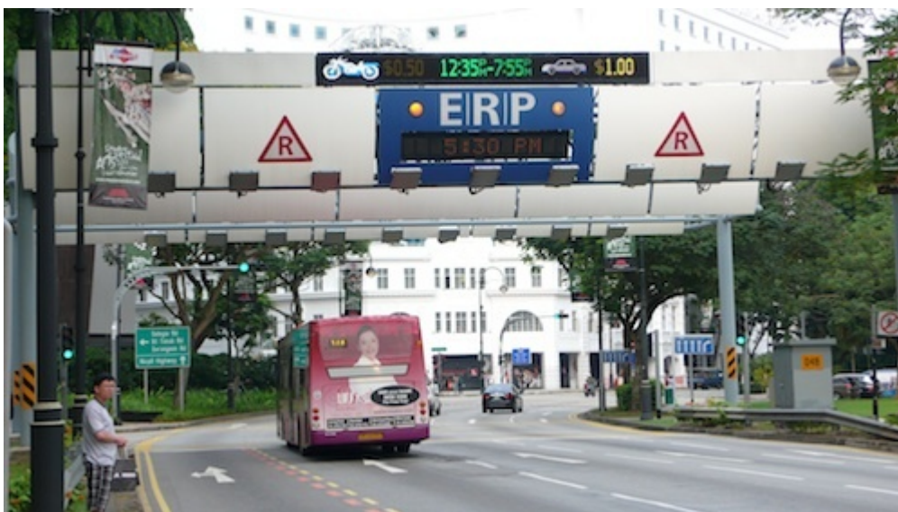
Photo 2 : portique de télépéage à Singapour © J.-Ch. Gay, 2011.
