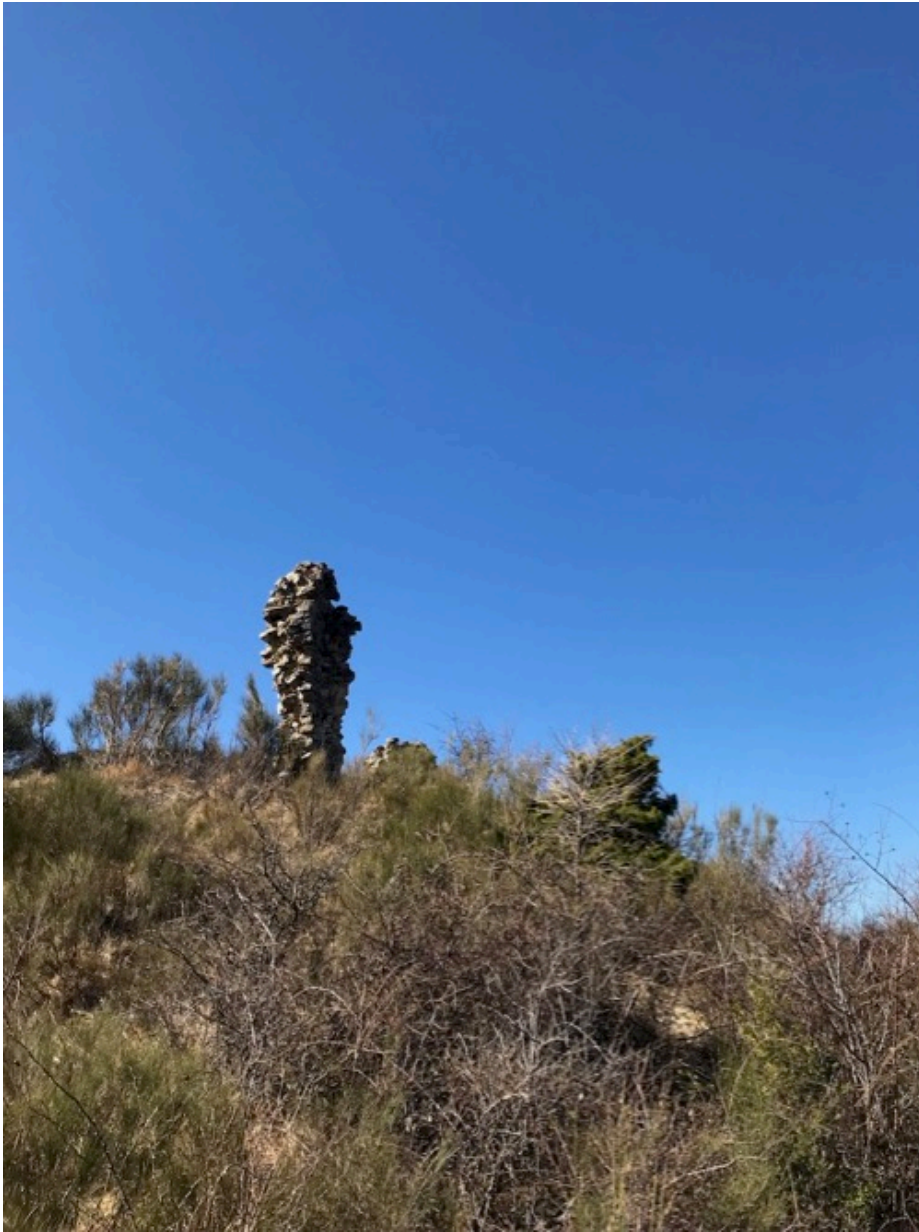
FIG.2 Les ruines du château de Vesc
