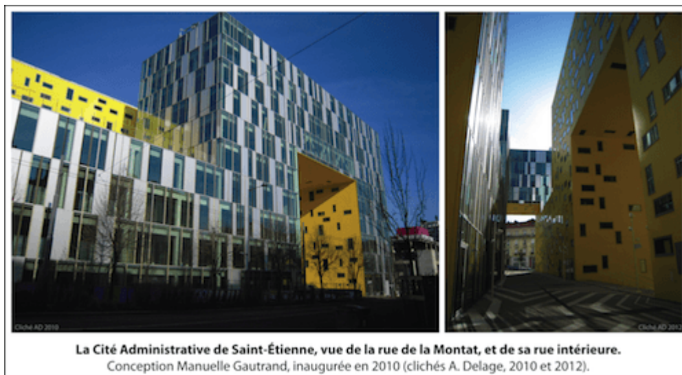
Photo 3 : La Cité Administrative de Saint-Étienne.
