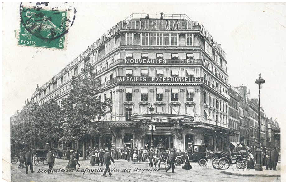
Figure 1 : Carte postale (datant de 1910) mettant en scène les Galeries Lafayette Haussmann et leur monumentalité architecturale. L'énoncé « vue des Magasins » renseigne sur la mise en regard de cet objet géographique (source : Jean-René Morice, collection particulière).
