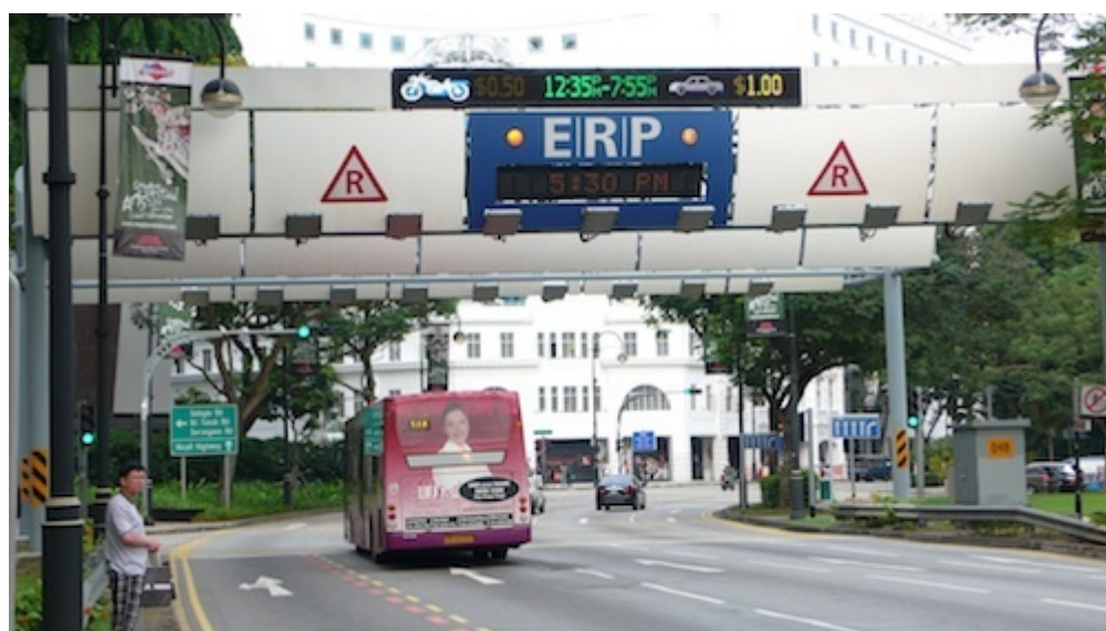
Photo 2 : portique de télépéage à Singapour © J.-Ch. Gay, 2011.
