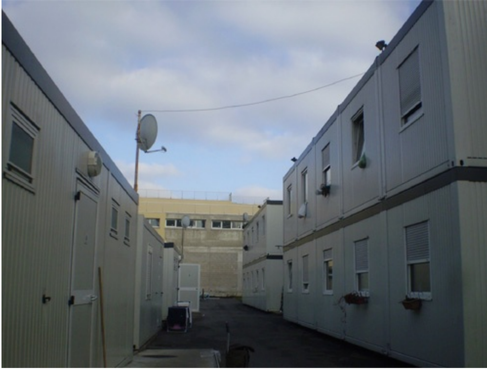
Les constructions modulaires du site d'hébergement et d'insertion de Bagnolet. Cliché : Olivier Legros, février 2009, avec l'autorisation de l'Alj 93.
