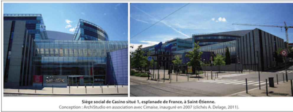
Photo 2 : Siège social de Casino, face à la gare de Châteaueux.
