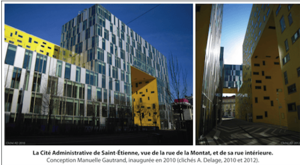
Photo 3 : La Cité Administrative de Saint-Étienne.
