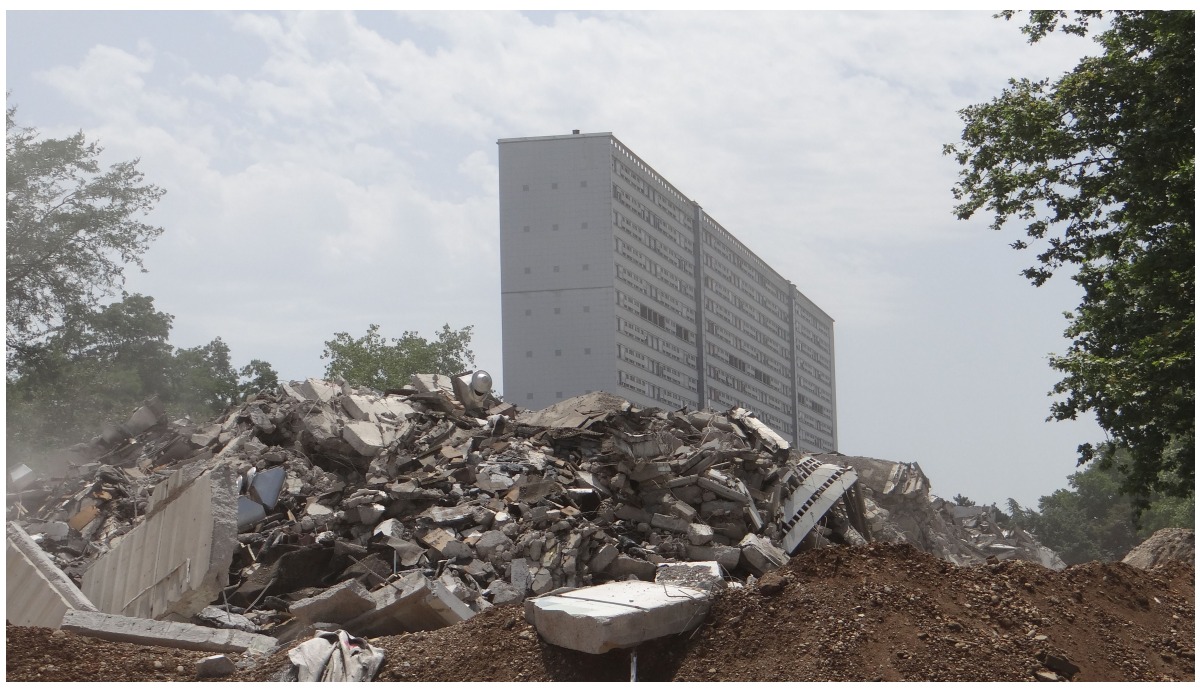
La Duchère, 2015. Le jour de la démolition de la barre 230. Photographie : Laëticia Mongeard.
