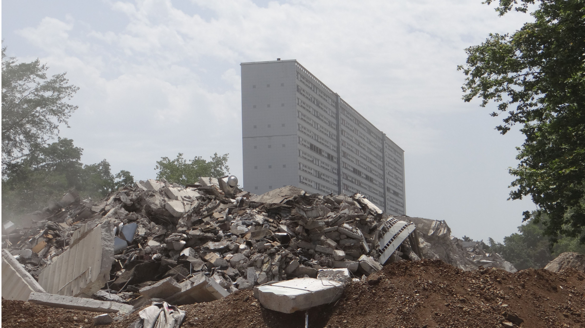
La Duchère, 2015. Le jour de la démolition de la barre 230. Photographie : Laëtitia Mongeard.
